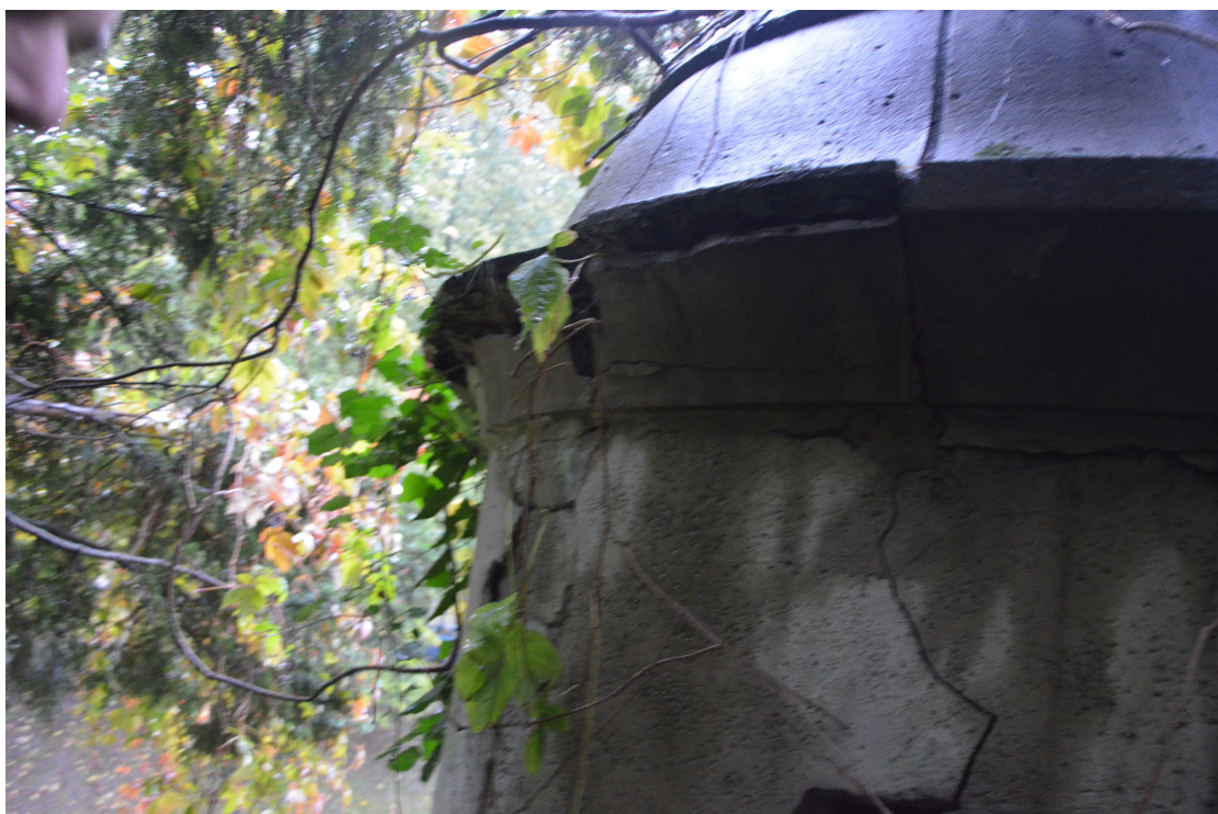
Zdjęcie nr 3.6. Kawaliera Południowa. Uszkodzenia dachu i ścian
